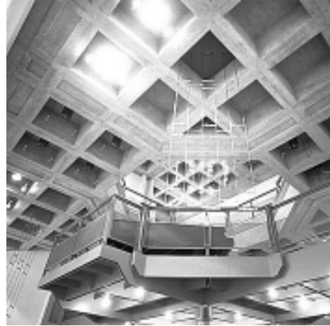
Vista del balcón ubicado en el hall
